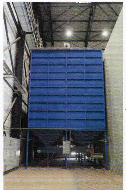
Afb. 5 Silo met bandlosser (rechtsonder) voor de belading van trucks
